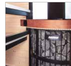
Barierki ochronne pieca wyposażone w oświetlenie LED
